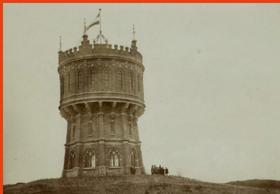
Ingebruikname van de watertoren en -leiding in Bloemendaal-Overveen 1898
